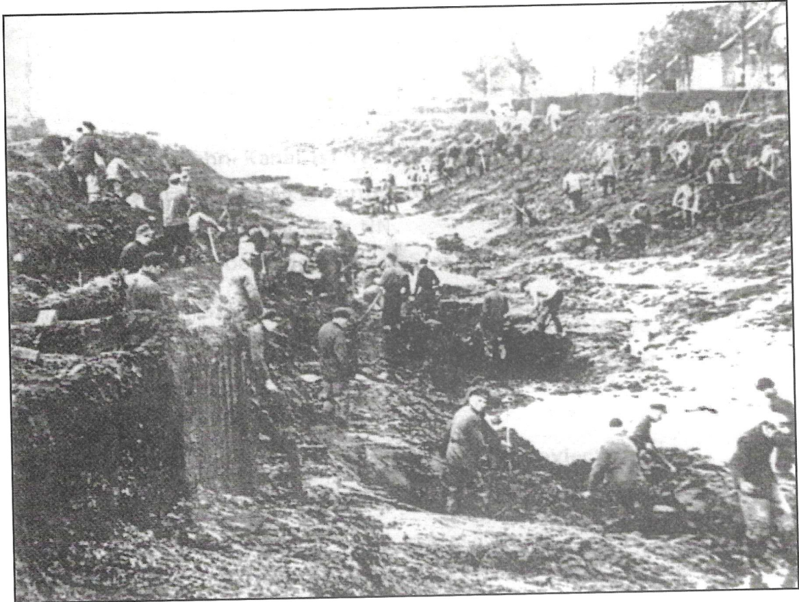
Kanalbett-graben per Hand 1921 in Wilhelmsfehn - Durchstich zum Nordgeorgsfehnkanal
